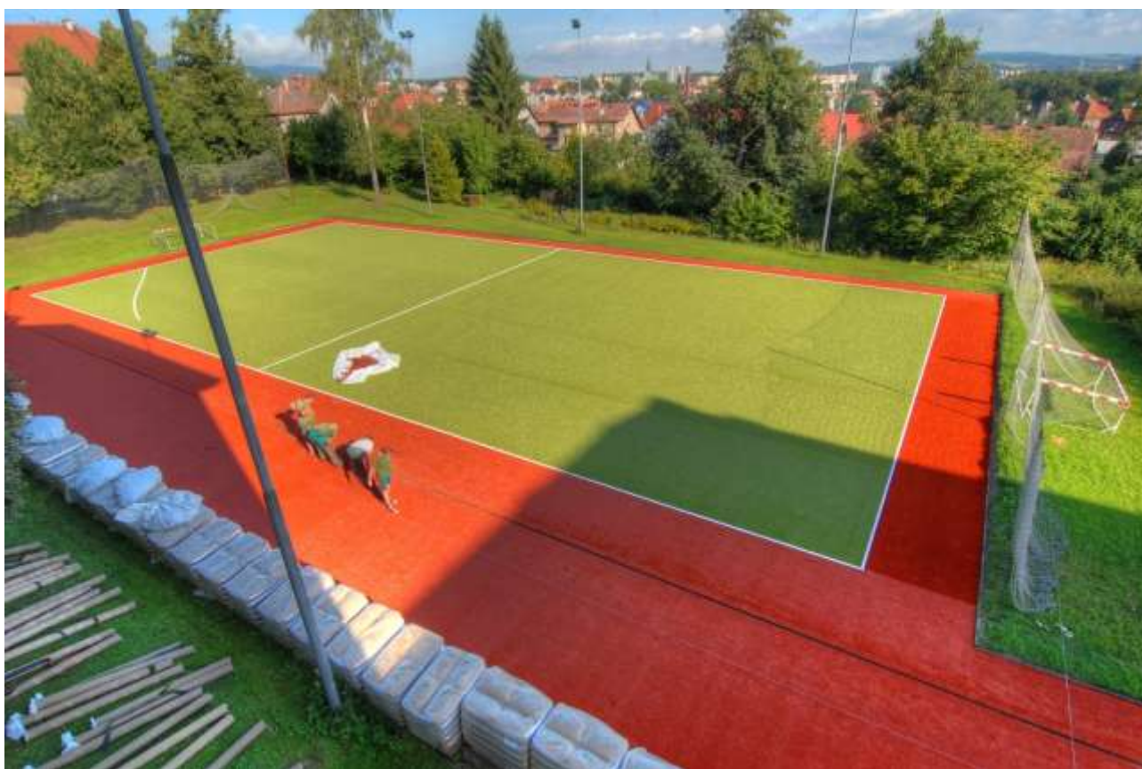
Oprava povrchu venkovního hřiště, pokládání nového koberce (srpen 2012)
