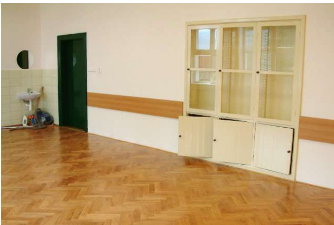
Opravy a rekonstrukce učeben ve 2. patře budovy A (červenec–srpen 2012), podlahy (parkety z chorvatského dubu), omítky, světla, hygienické zázemí
